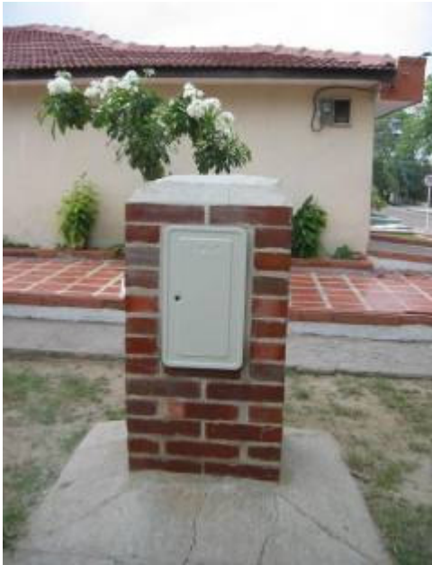
Ejemplo 2. Dispositivo de recolección de muestra de agua para consumo humano utilizado por Triple A de Barranquilla.
